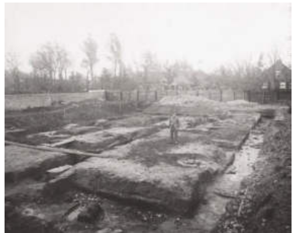
Opgegraven fundamente anno 1911 (7)
